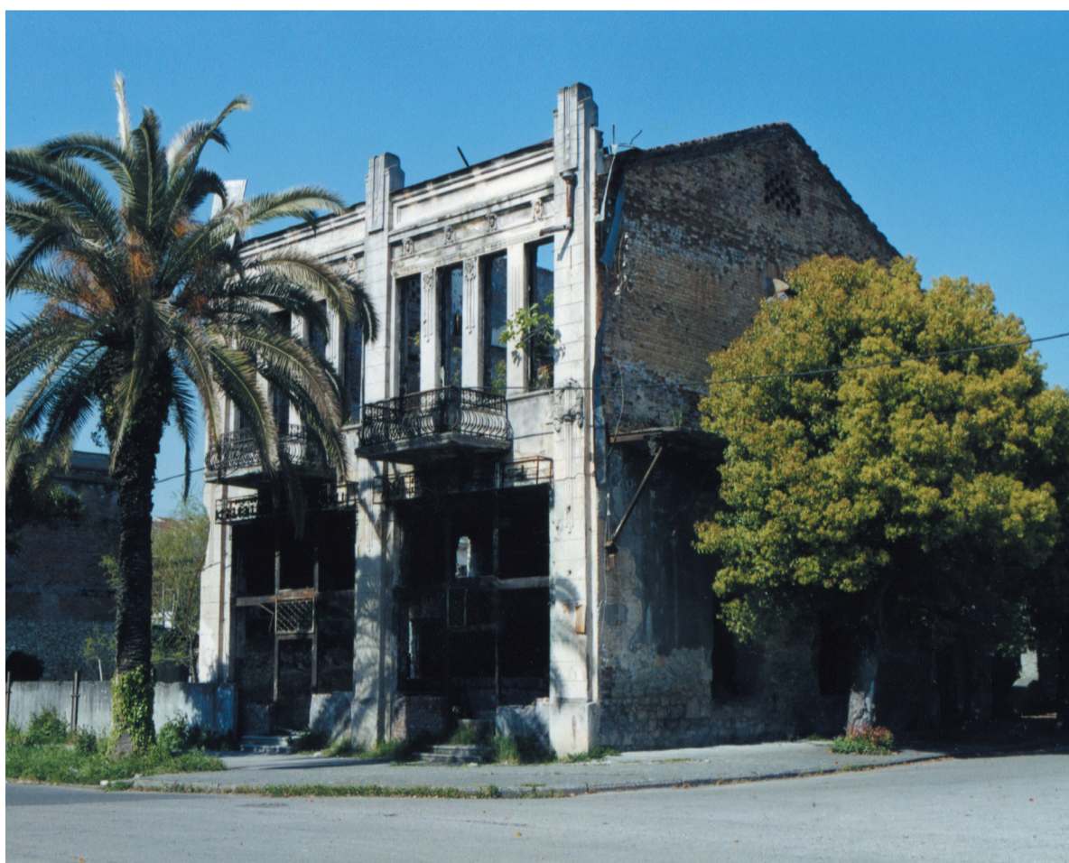
Здание бывшей гостиницы «Венизелос» после разрушения в 1993 г.
