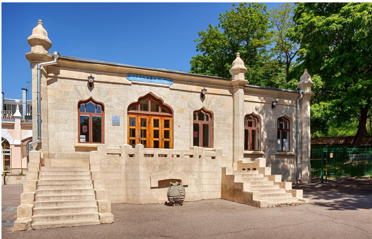
Галерея источника №17 в Ессентуках
