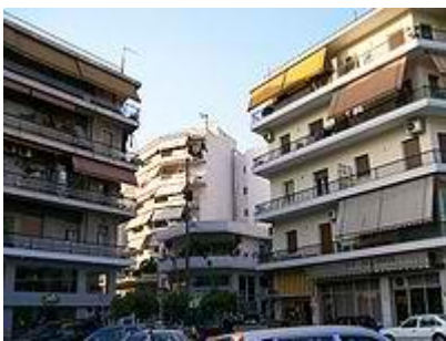
Типичные для Греции дома с балконами и террасами, афинский район Неос Космос
