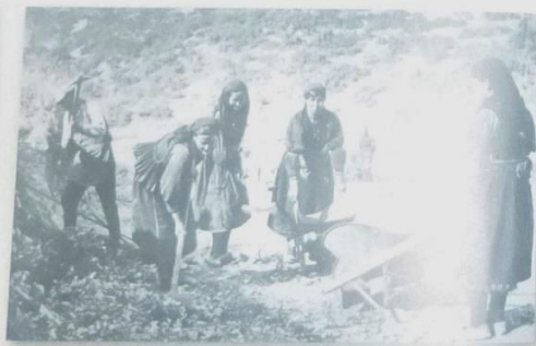
Διάνοξη δρόμου από Ημερωπώτες
